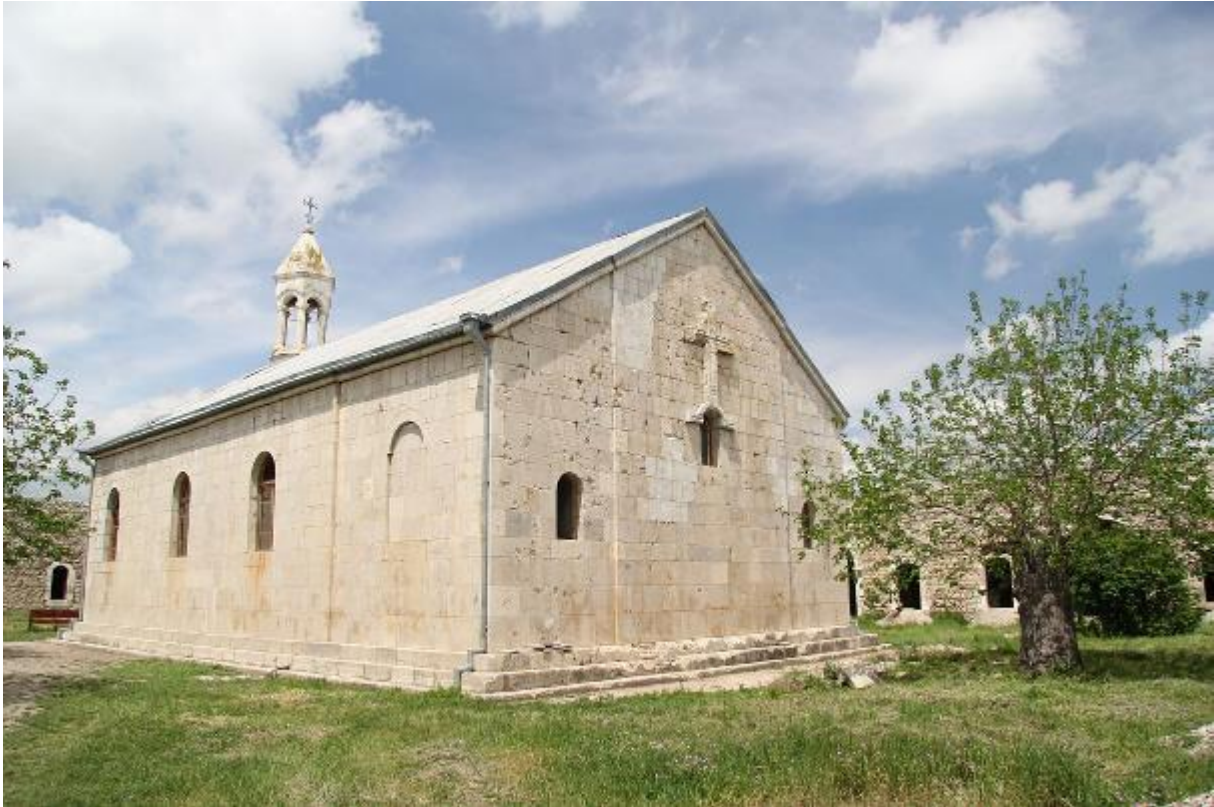
Kloster Amaras (5. Jh.). Letzte umfangreiche Renovierung 1858 durch die Bürger von Schuschi (Bild von z. Galstyan)
